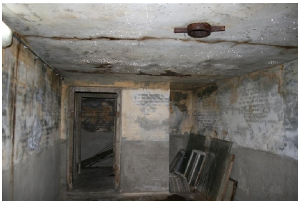
Interieur schuilkelder vanaf de ingang
