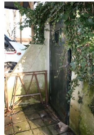
Toegang tot de schuilkelder
