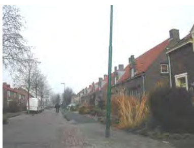
Herhaling en ritmiek in het gevelbeeld door schoorstenen, dakkapellen en identieke gevelindeling.
