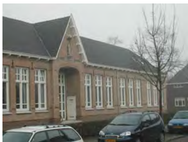
Beeldbepalend pand van de St. Jozef-school in de Laagstraat met fraai gedetailleerde gevel.
