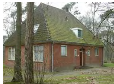
Vrijstaande bebouwing opgebouwd uit één bouwlaag en een hoog schilddak.
