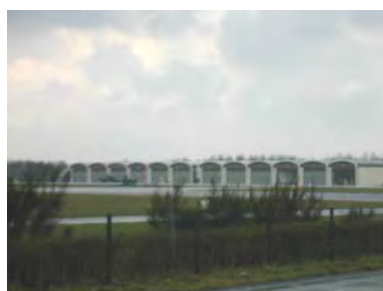
Verticaal geledede gevels door hangardeuren.
