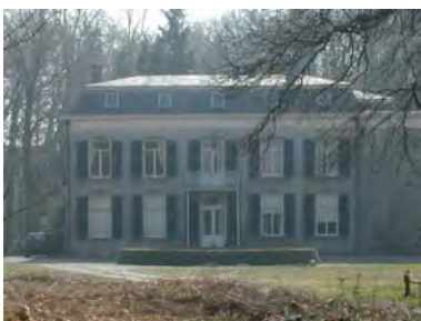
Verticale gevelgeling met T-vensters, fraaie omlijsting, luiken en sierbalkons.
