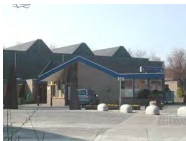
Geknikt dakvlak met grote overstek accentueert entree van de sporthal.
