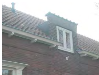
Doorgetrokken gevel in kleine dakkapellen.
