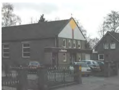
Rietakkers met opvallende lichte gevelbeplating in de punt van de kopgevel.
