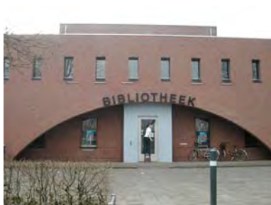
Bebouwing uitgevoerd in metselwerk.
