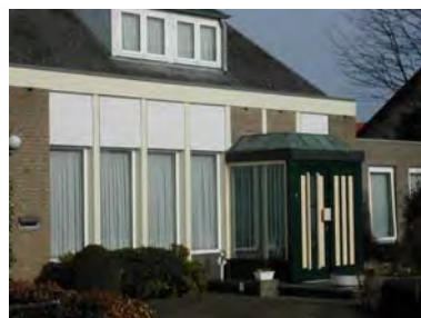
Ongestructureerde gevelindeling, kleurgebruik en toevoegingen aan de gevel zijn storend in het gevelbeeld.
