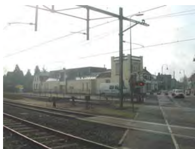
Gedifferentieerde gevelwanden langs de spoorlijn.
