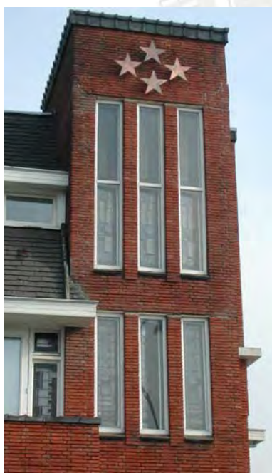
Fraaie detaillering van villa/kantoor van vml. lederfabriek 'De Adelaar'.
