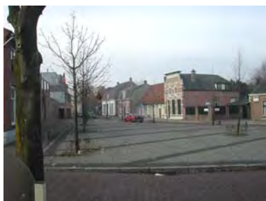
Gedifferentieerde gevelwanden met gevarieerde bouwhoogten en kapvormen.
