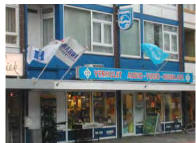
Felle kleuren en schreeuwerige reclames domineren het gevelbeeld nabij het gemeentehuis.
