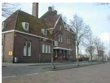
Stationsgebouw centraal element binnen de spoorzone.
