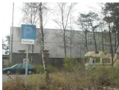
Gesloten gevelwanden van de sporthal met lichte gevelbeplating.
