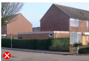
Niet passend door plaatsing in voorgevellijn.
