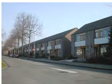
Rijenwoningen in de rooijlijn geven een samenhangend straatbeeld.
