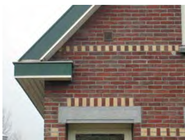
Fraaie detaillering met overstek, siers metselwerk en betonnen latei.
